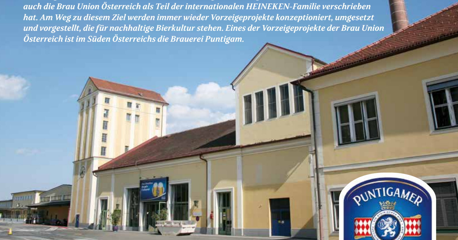
Die Brauerei Puntigam: einzigartiges Energieversorgungskonzept mit biogener Gärwärme.
